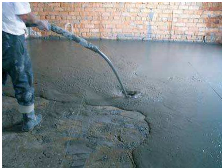
圖三、以一體澆注泡沫混凝土施作隔熱層
